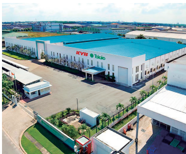
ベトナム第一工場
