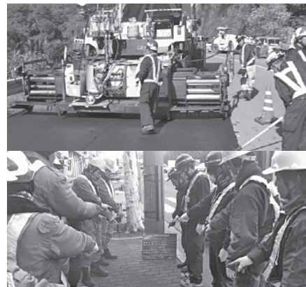
火気を扱わないことで現場環境が改善
