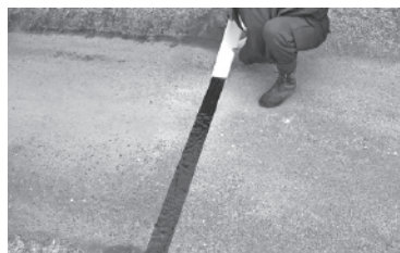
アステープを使用した舗装工事
