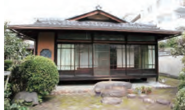
一部の部材を再活用し保存・再生する解体前の画室外観
