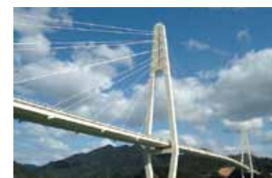
④ クレーンブリッジ
