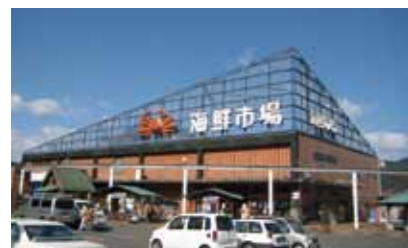
① 道の駅 舞鶴港とれとれセンター（*）
