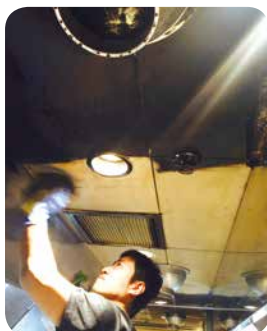
厨房の天井を隅々まで丁寧に洗浄
