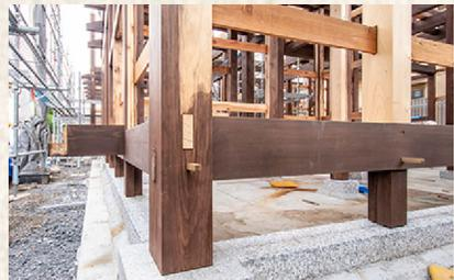
構造体には釘や金物を使わず施工しています。また、室内の壁は土の中塗り仕上げとし、質感を残すことにより、壁の立体感を演出しています。
