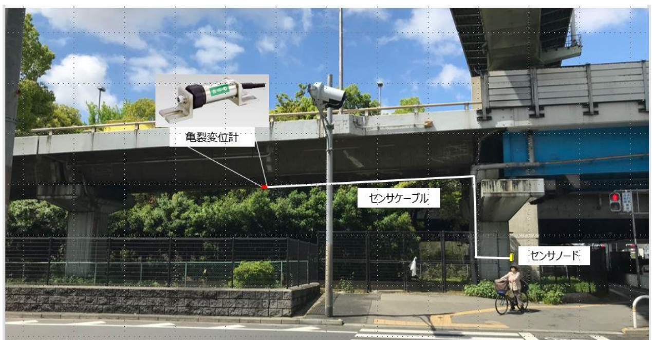
亀裂変位計とセンサノードの位置関係 (提供：大阪大学大学院 小泉圭吾助教)
