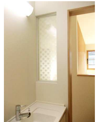
絹紋紗の生地を挟み込んだ「絹ガラス」が化粧台の袖壁に映える施工例
