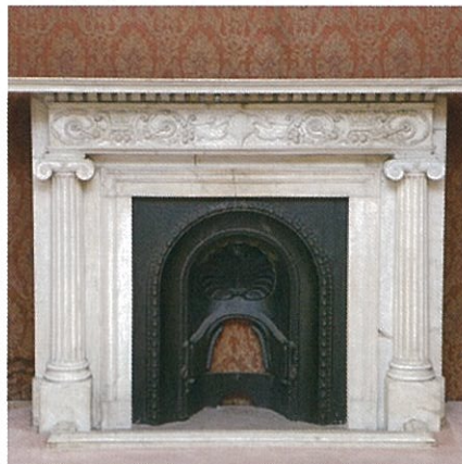
二代目ビルの遺構②「暖炉」 3階の特別応接室には、二代目ビルの暖炉が移築されている。暖炉として使用することはできないが、当時の重厚な造りが見て取れる。
