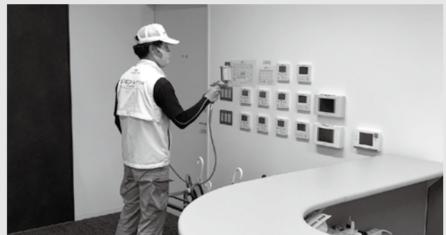
■ 照明・空調パネルなども施工済み
