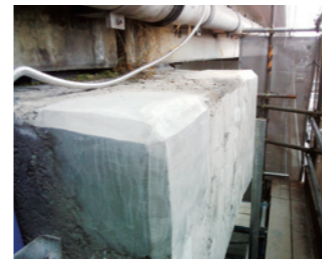
改修に携わった高架橋の一部分
