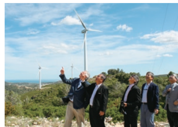
54基の風力タービンが稼働するコラデテス風力発電所
