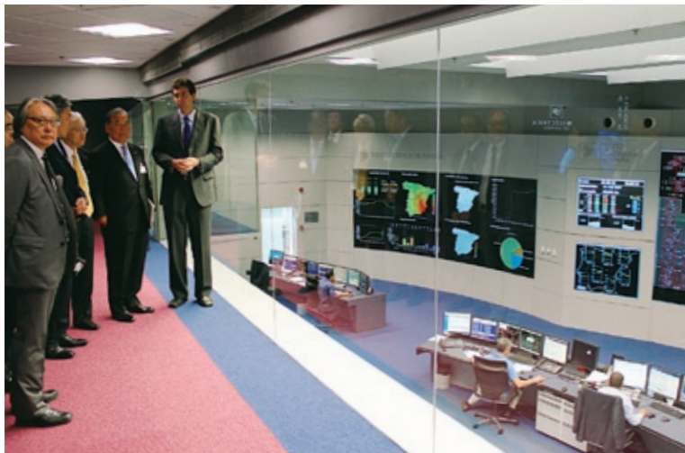
スペイン全土の発電状況を監視・制御するREE社の中央給電指令所
