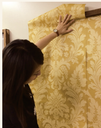
輸入壁紙施工の様子。
