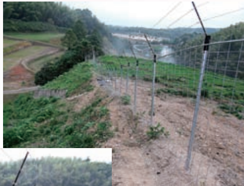
獣害防止ネット、名付けて「イノシッシ」。設置場所を選ばず、土地の形状に応じて利用可能。
